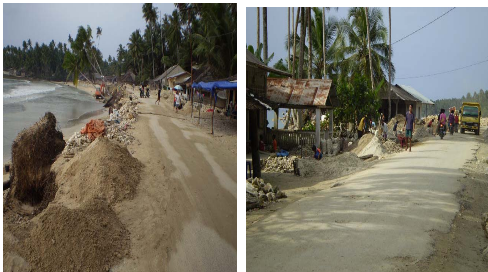
Gambar. 2.5. Menyempitnya lebar jalan Photo : Oktober 2007, Kecamatan Telukdalam-Nias Selatan
